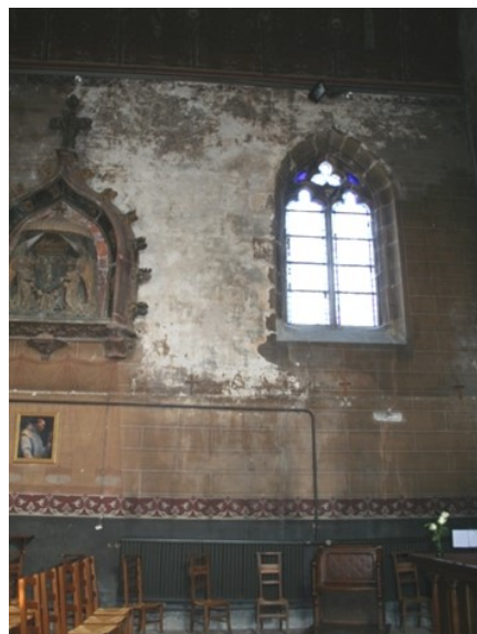
Bas-relief de la Chambre des Comptes avant restauration
