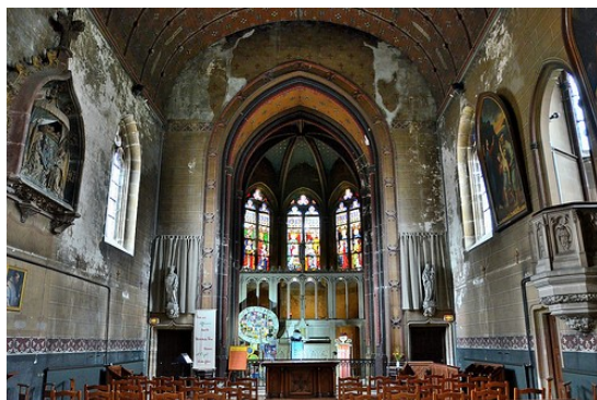
Décors du chœur avant restauration
