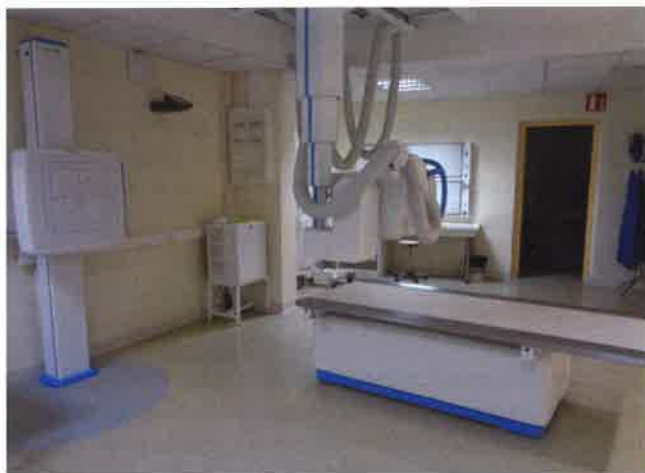
Figure: Le CH La Chartreuse est équipé d'une salle de radiologie comportant une table à plateau flottant, un potter mural, une suspension plafonnière et un capteur plan.
