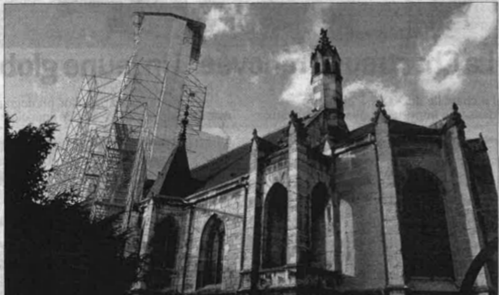
Le chantier a été financé à hauteur de 40 % par l'État, le centre hospitalier spécialisé prenant en charge les 60 % restant. Trois autres tranches de travaux ont également été évoquées. Photo M. Mo.
